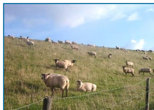
Mäharbeiten am Deich
